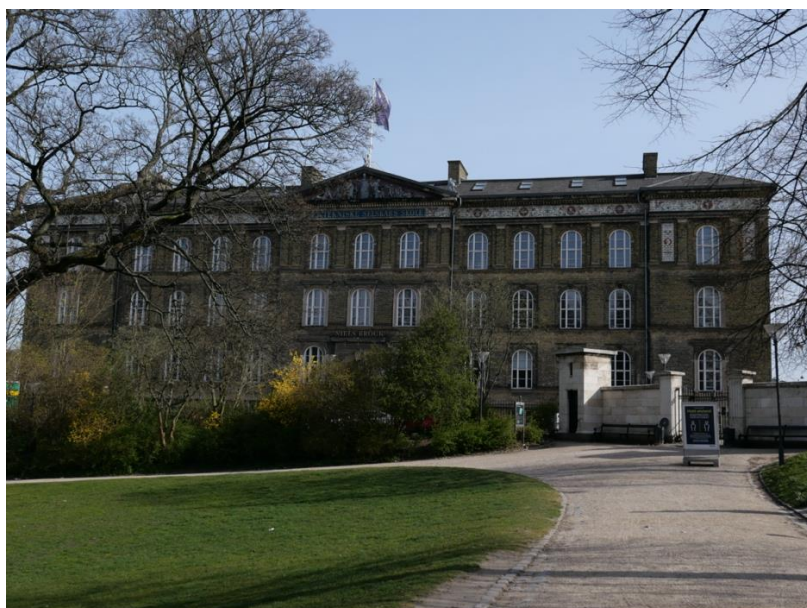
Det Tekniske Selskabs Skole, som er beliggende lige uden for Ørstedsparken. Bemærk flisefeltet på øverste etage til venstre for risalittens vindue.
