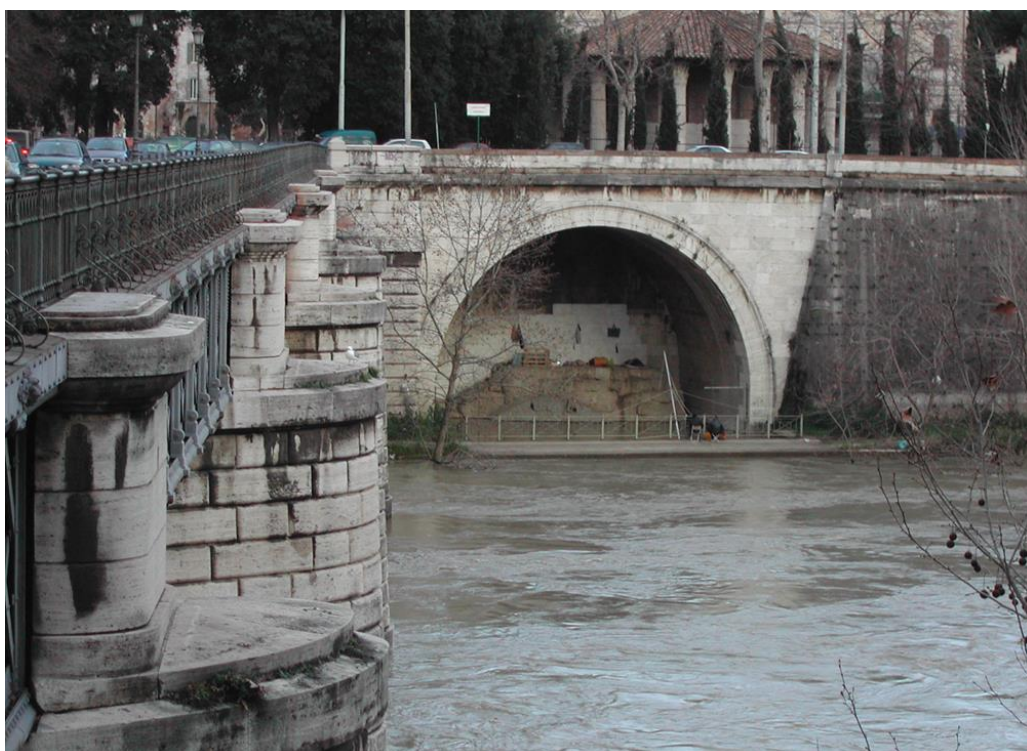
Cloaca Maxima's udmundning kan ses lige ved siden af Ponte Palatino ved Tiberen, der i antikken var Roms vigtigste transportvej. Den imponerende bue antyder, at kloakken var hellig, og at man ikke forsøgte at skjule den.
